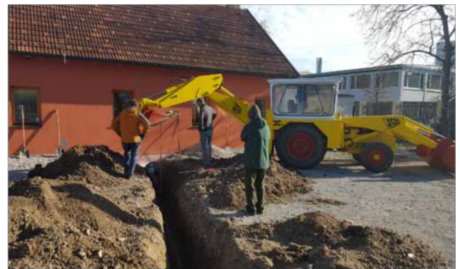
Baggerarbeiten am Parkplatz
