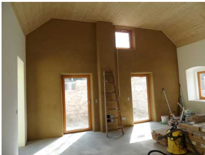
Atelier mit Lehmputz
