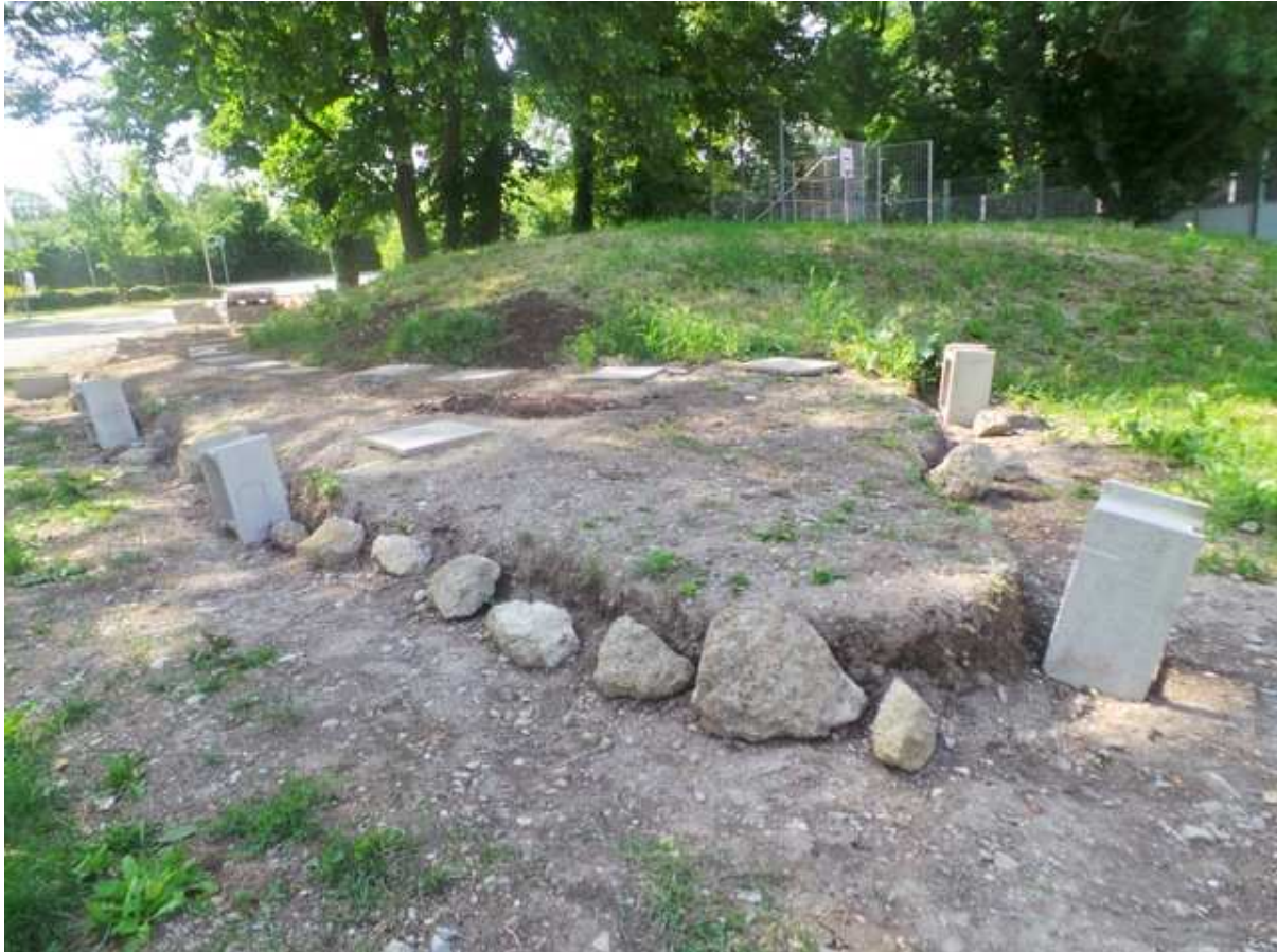
Vorbereitung des Geländes
